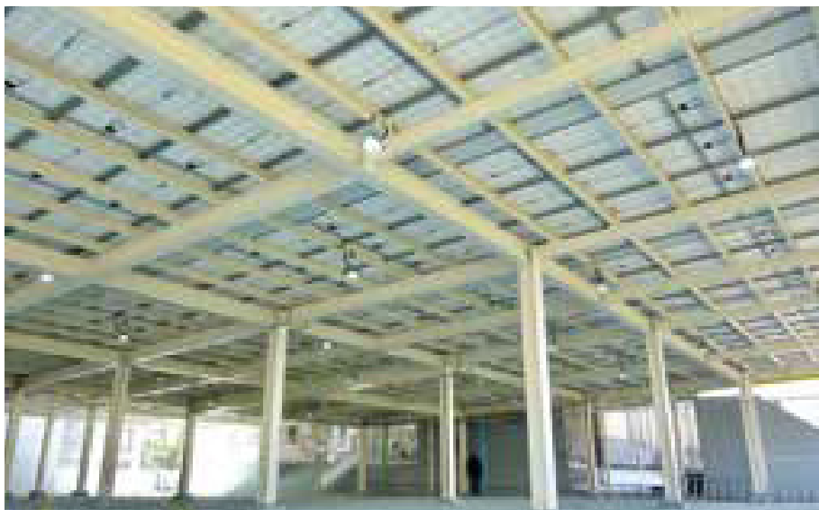
承德陽光活力廣場達之太陽能板直接架空以提高透光率
